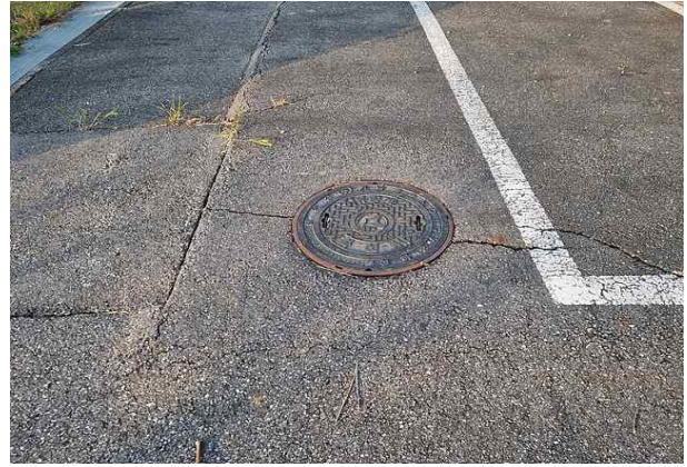
환기구 등의 덮개(유량계실 입출구) 현황
