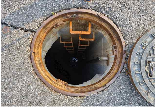
유량계실 출입구 전경
