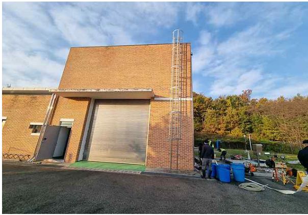
옥상층 진입사다리 상태양호
