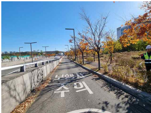
송수-1,2 시점부 전경
