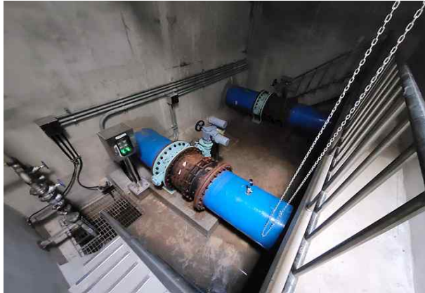
유입배관실 내부 전경
