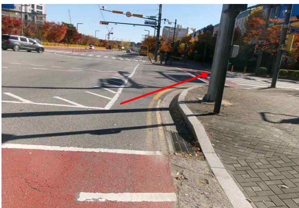
위 치 송수-6 (Sta.1+0.0) 손상내용 포장 및 지반 상태양호
