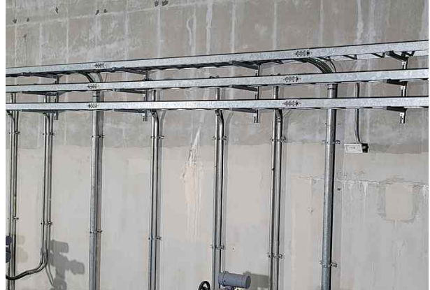
손상내용 펌프실 지하 내부벽체 백태 손상원인 열화부 수분침투
