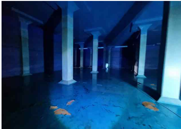
배수지 1지 내부 전경
