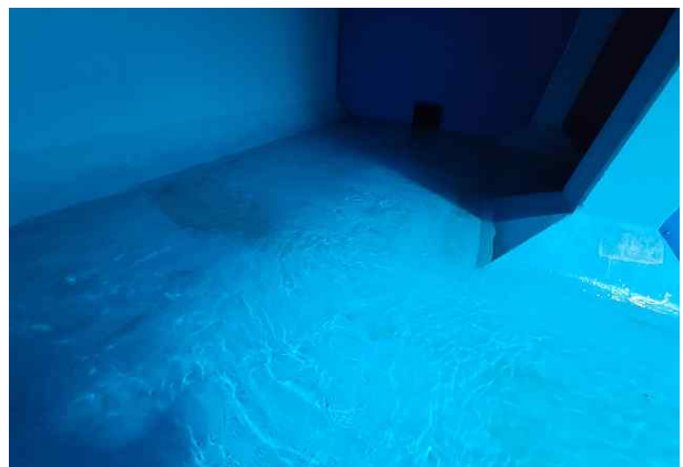
손상내용 1지 바닥슬래브 상태양호 손상원인 -
