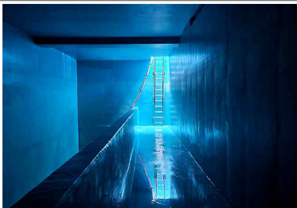
저류조 및 흡수조 1지 내부 전경
