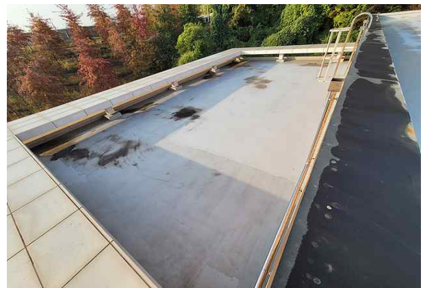
손상내용 건축물 옥상 방수층, 파라펫 상태양호 손상원인 -
