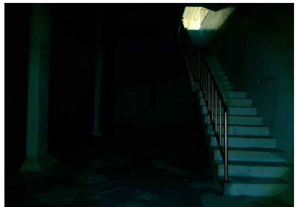
배수지 4지 내부 전경
