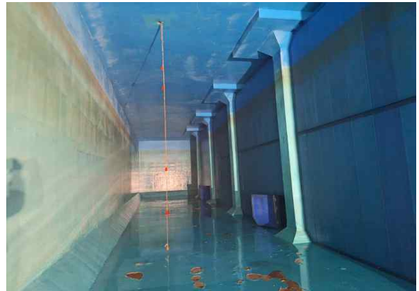
배수지 2지 내부 전경
