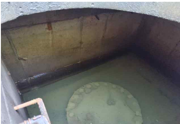
위 치 송수-2 Sta.49+13.3(제수) 손상내용 구조물 및 밸브 상태양호
