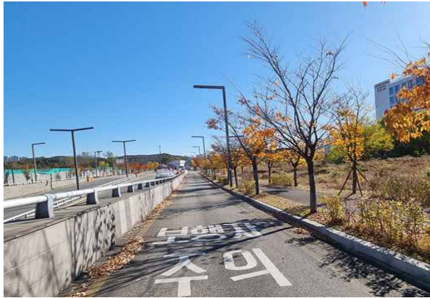
송수-1,2 시점부 전경
