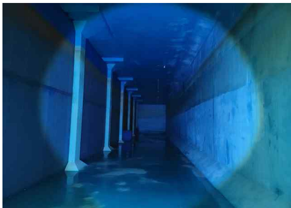
배수지 3지 내부 전경
