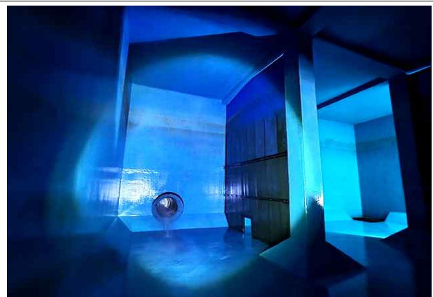
저류조 및 흡수조 2지 내부 전경
