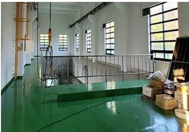
손상내용 펌프실 지상1층 안전난간 상태양호 손상원인 -
