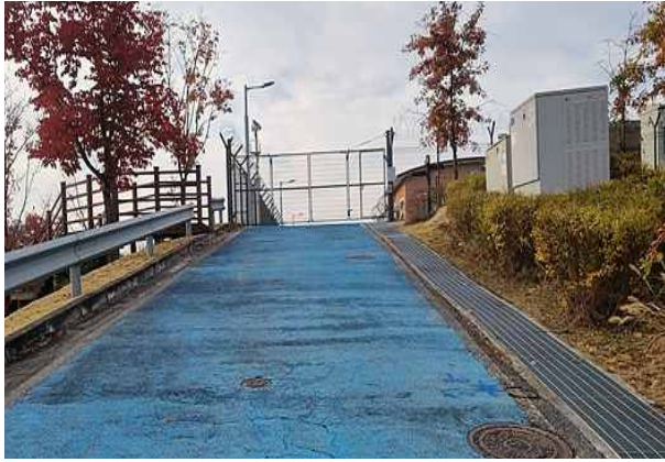
진입로 포장 현황
