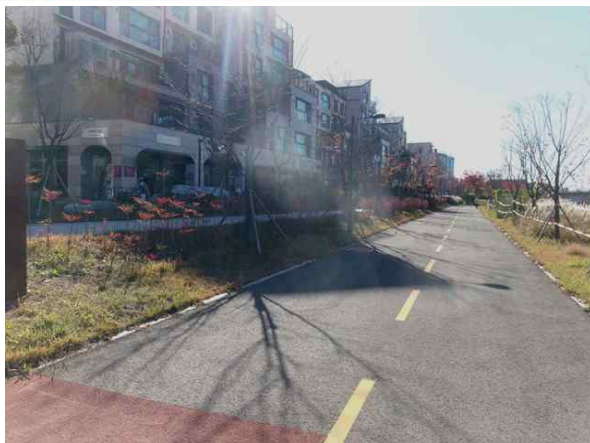
송수-4,5 시점부 전경
