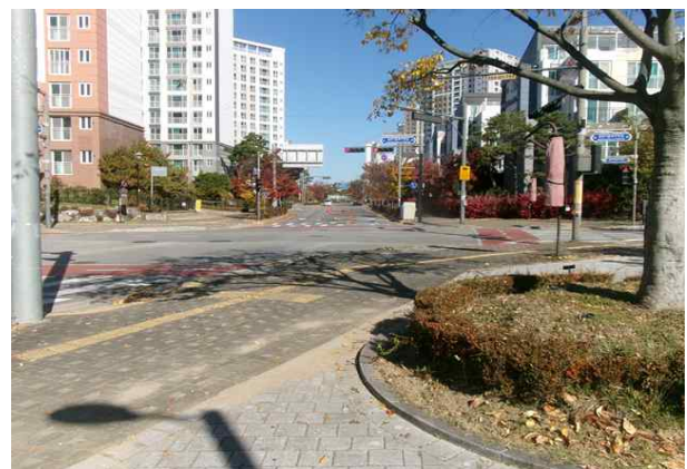
위 치 송수-6 (Sta.14+17.0) 손상내용 포장 및 지반 상태양호
