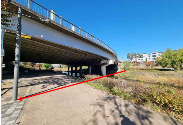
위 치 송수-1, 2 (Sta.66+1.0) 손상내용 포장 및 지반 상태양호
