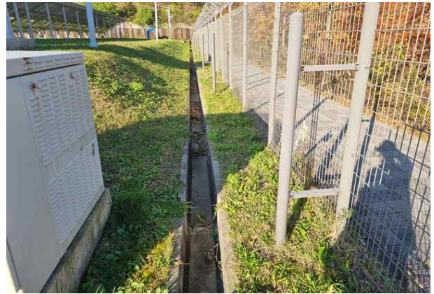
측구 배수로 현황
